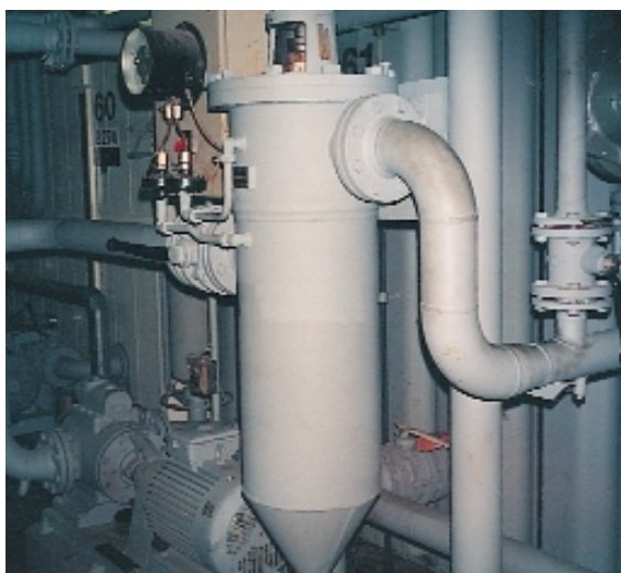
Automatický filtr Metal Edge se stěrkovým čištěním na isokyanát (složka PU)
